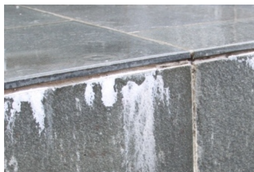
Figur 8: Unngå kantavslutninger med flis som ligger an mot sidekant flis på betongdekket.
