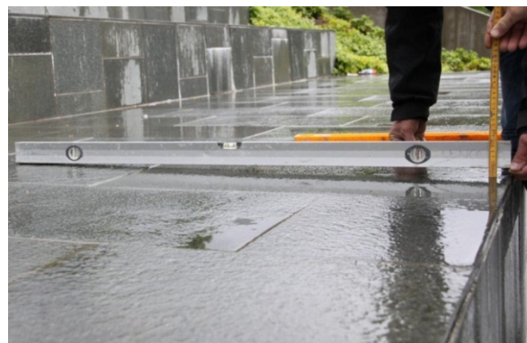
Figur 2: Flaten skal ha godt fall uten svanker så vannet renner raskt bort.
