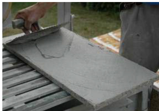
Figur 3: Med dobbelliming påføres lim på flisa med slettsparkel.
