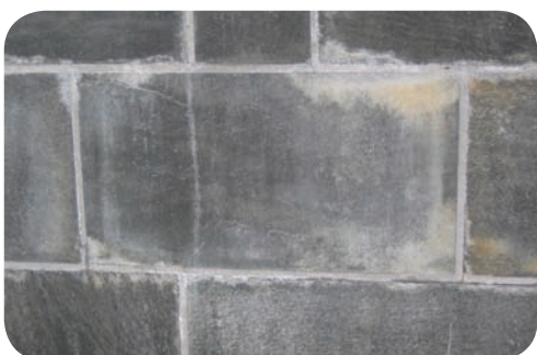
Eksempel på salt- og kalkutslag.
