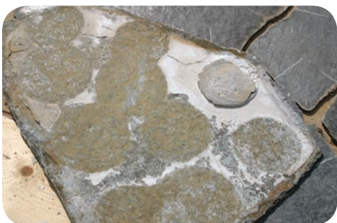
Eksempel på dårlig limdekning.
