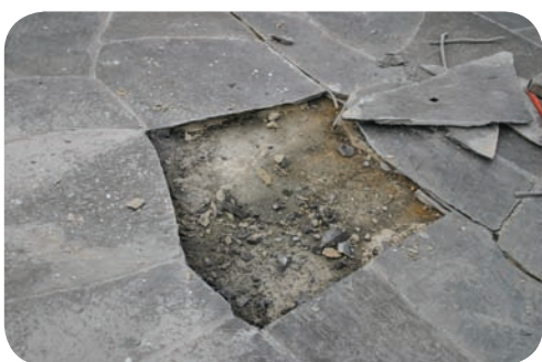
Eksempel på frostsprengning.
